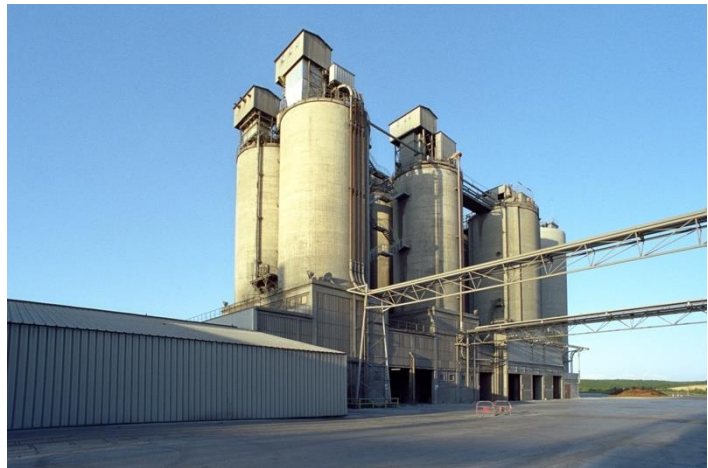
Unité de stockage de la cimenterie d'Airvault – Source : Ciments Calcia
