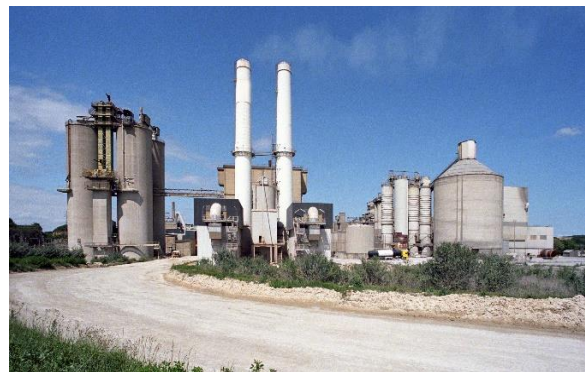
Cimenterie d'Airvault – Source : Ciments Calcia
