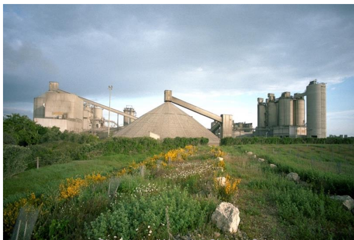
Cimenterie d'Airvault – Ciments Calcia
